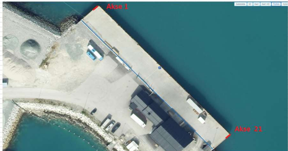
Figur 2 - Oppsummering registrering av sprekk åpning mellom kaidekke og overgangsplate
