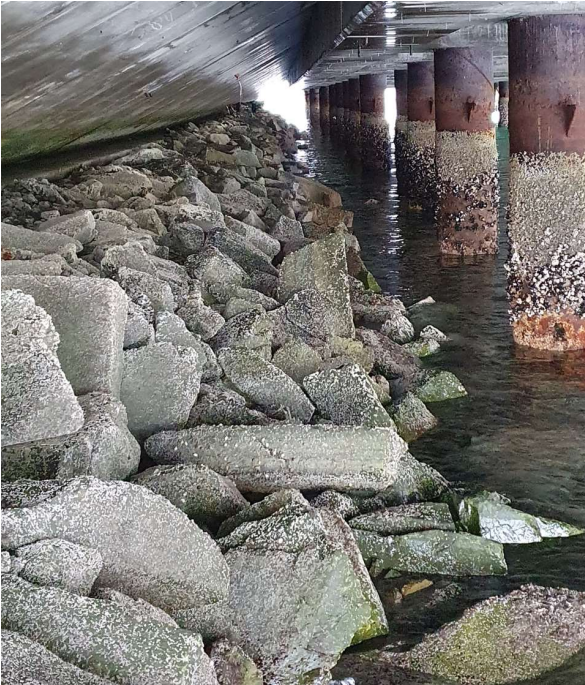
Foto 2 - Bilde 2023 - Erosjonssikring under kai
