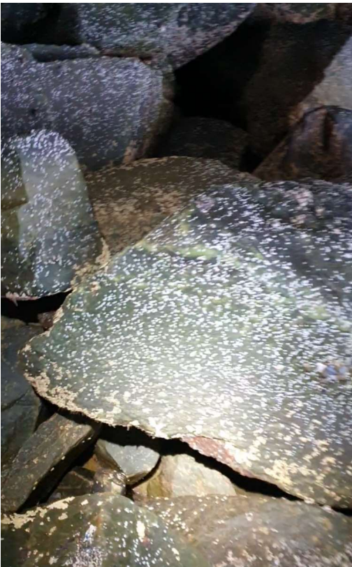
Foto 3 - Små stein bak plastringsstein
