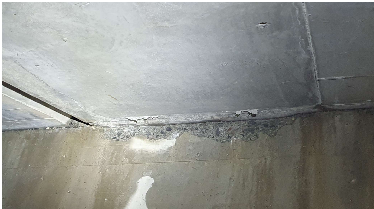
Foto 13 - Opplegg overgangsplate på bakkantbjelke
