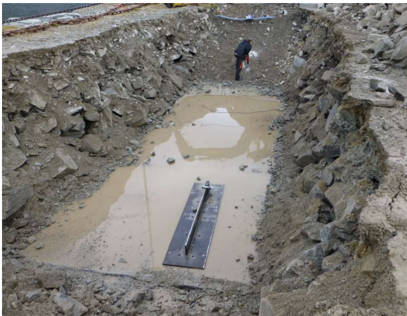
Foto 11 - Bilde fra 2014 - Tiltak etablering av strekkforankring
